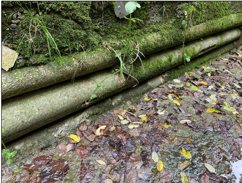
Figura 11: Muro esistente sponda sinistra
