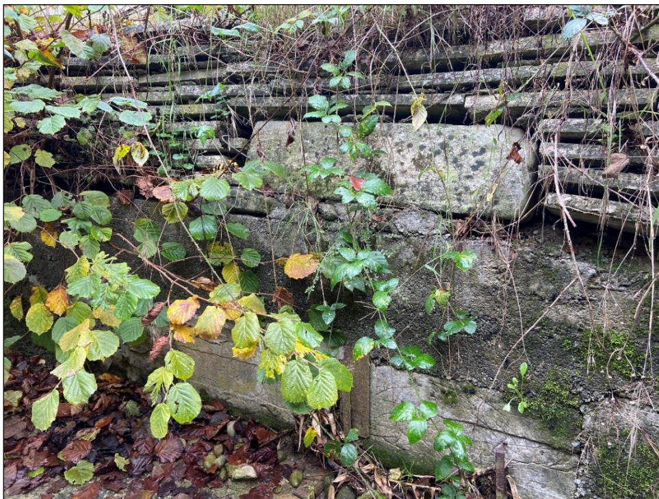
Figura 12: Muro esistente sponda sinistra
