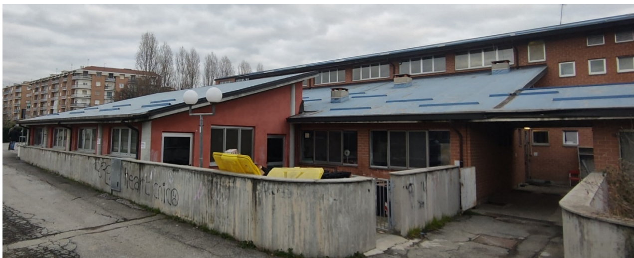
Vista di una delle falde con rattoppi in corrispondenza delle sovrapposizioni
