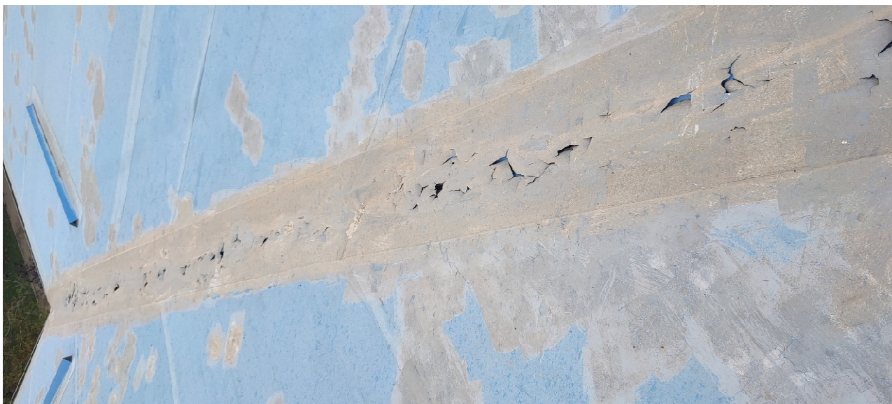
Fessurazioni diffuse in corrispondenza dei compluvi
