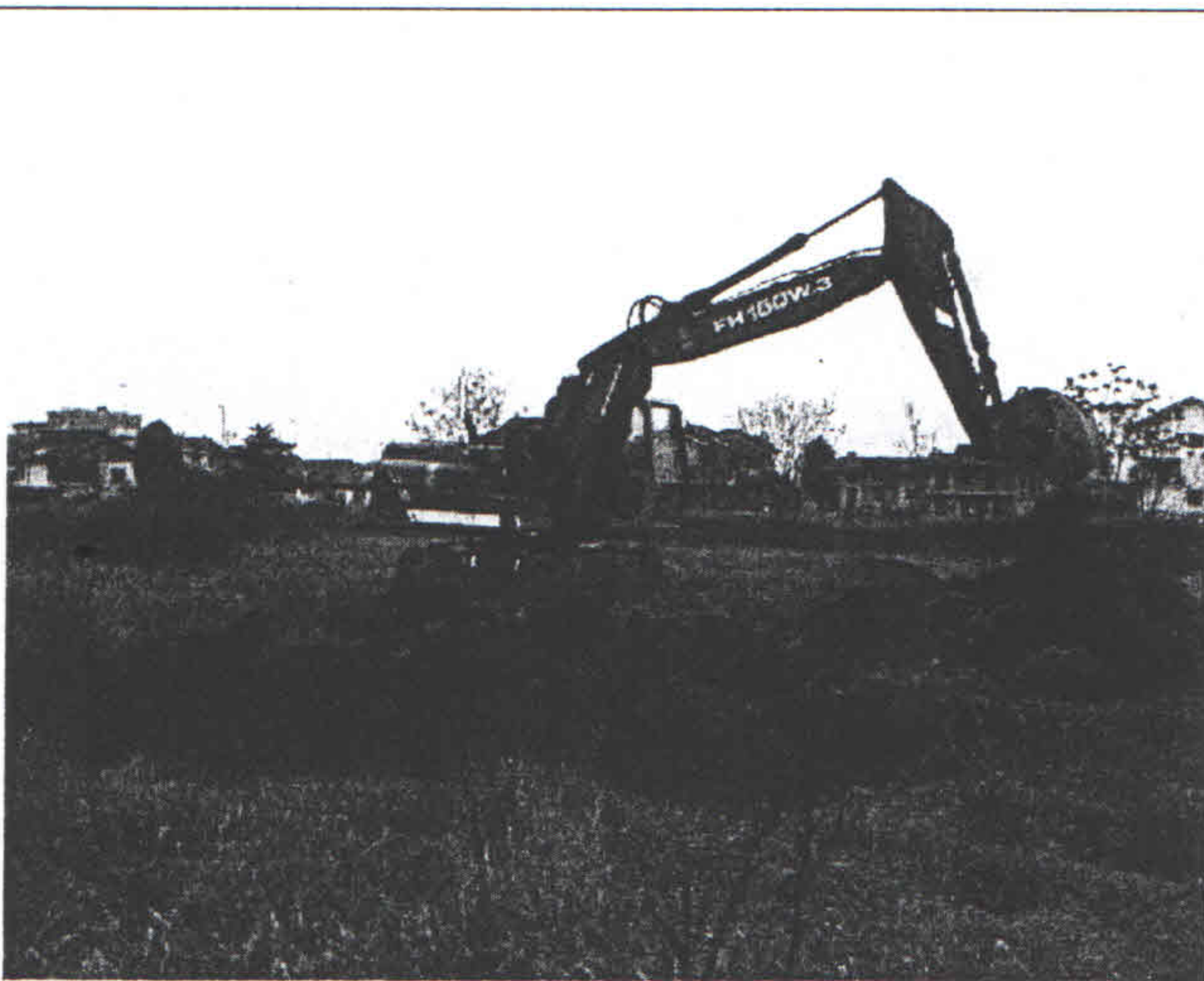
Foto 7-8: Sopra: scavo del pozzetto geognostico P4 con mezzi meccanici. Destra: particolare del fondo del pozzetto con evidenza della omogeneità del deposito.
