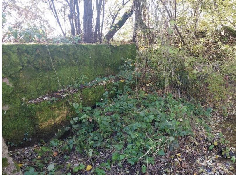
*Foto 1 – Soglia funzionale alla derivazione in destra e alla stabilizzazione del fondo alveo. Imbocco della derivazione*
