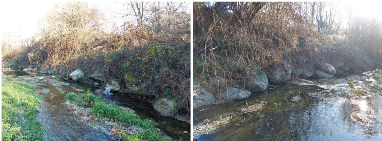
**Figura 14 – Stato dei luoghi a ridosso degli stabilimenti Sparco e Sacrima. Scogliere in sinistra idrografica a monte degli stabilimenti che necessitano di interventi di protezione e sottofondazione del piede**
