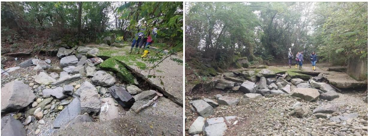
**Figura 1 – Soglia fissa funzionale a una derivazione irrigua ormai in disuso e alla stabilizzazione del fondo alveo. Condizioni di dissesto**
