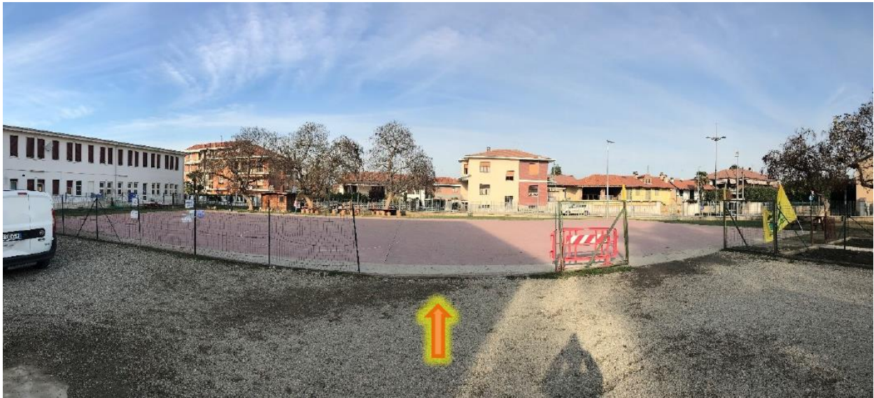
Vista dell'accesso dalla Scuola Primaria
