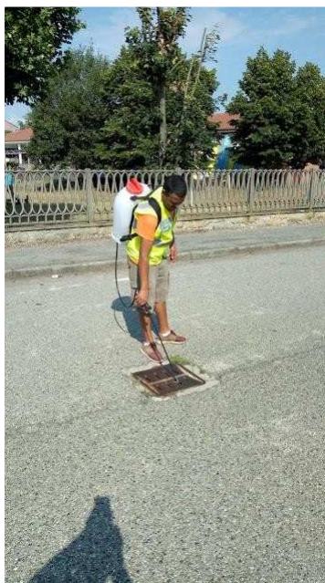
Operatore Ditta Sanatec
