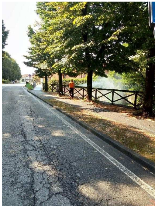
Intervento sul Rio san Giovanni in via Brandizzo
