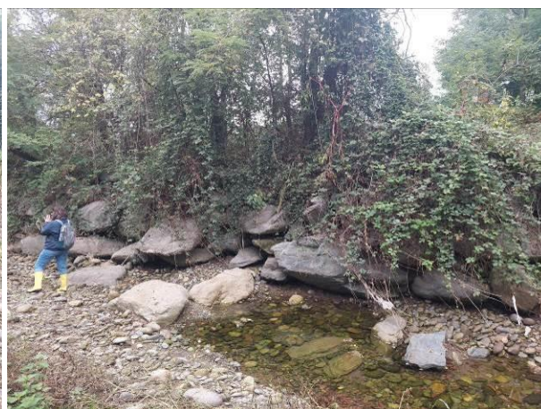
Figura 3 – Erosione al piede delle scogliere presenti in sinistra idrografica circa 100 m a valle della soglia
