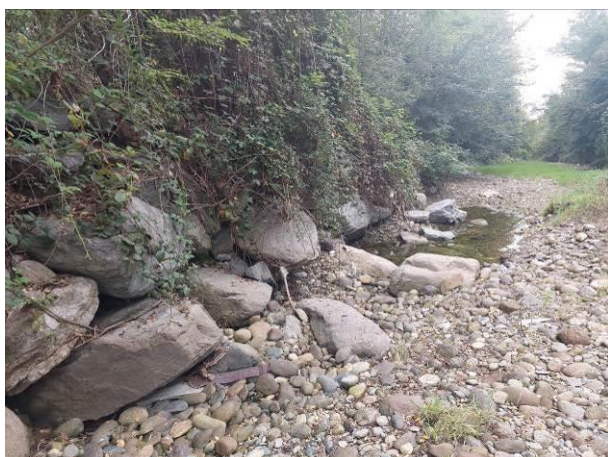
Figura 3 – Erosione al piede delle scogliere presenti in sinistra idrografica circa 100 m a valle della soglia
