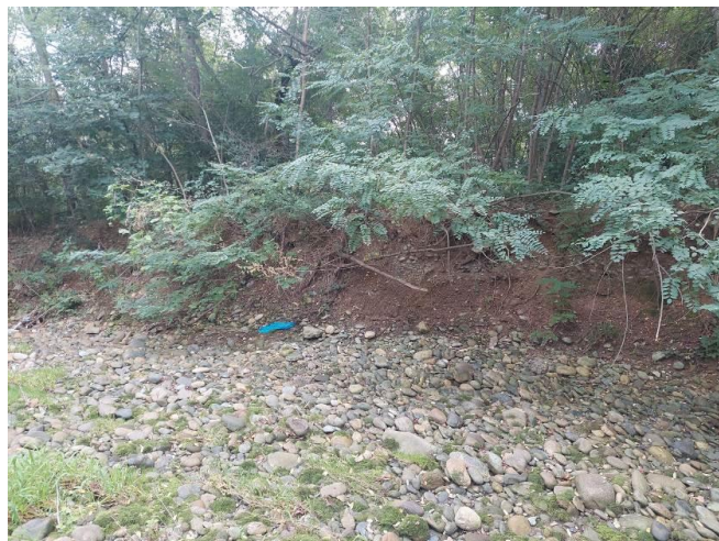
Figura 2 – Erosione di sponda destra a valle della soglia
