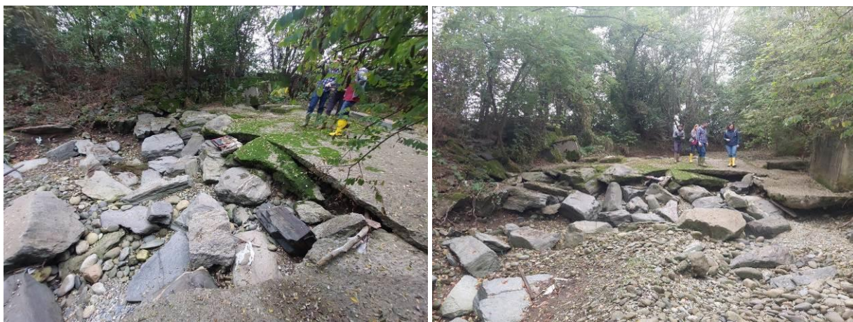
Figura 1 – Soglia fissa funzionale a una derivazione irrigua ormai in disuso e alla stabilizzazione del fondo alveo. Condizioni di dissesto
