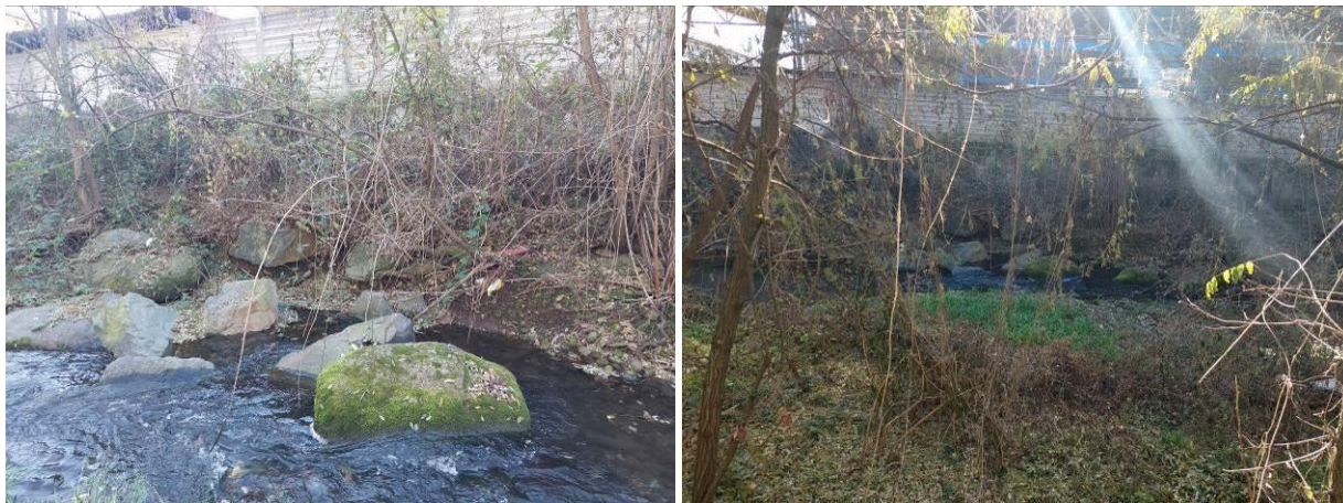
Figura 5 – Stato dei luoghi a ridosso degli stabilimenti Sparco e Sacrima. Erosione di sponda e asportazione delle scogliere
