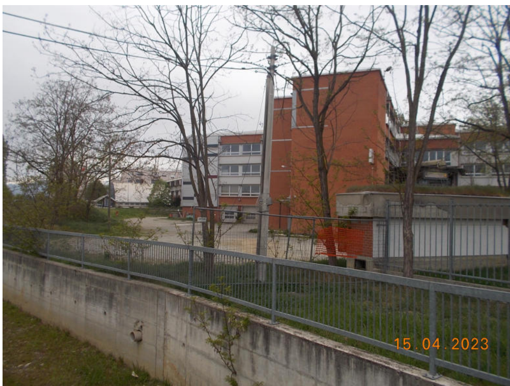
Figura 1-1 – L'edificio di Via Sottoripa 3 con, a sinistra, la facciata Sud al cui piano terreno si propone la realizzazione della biblioteca civica. In primo piano il muro di sponda sinistra del Rio San Giovanni (foto 3625-DSCN7222)
