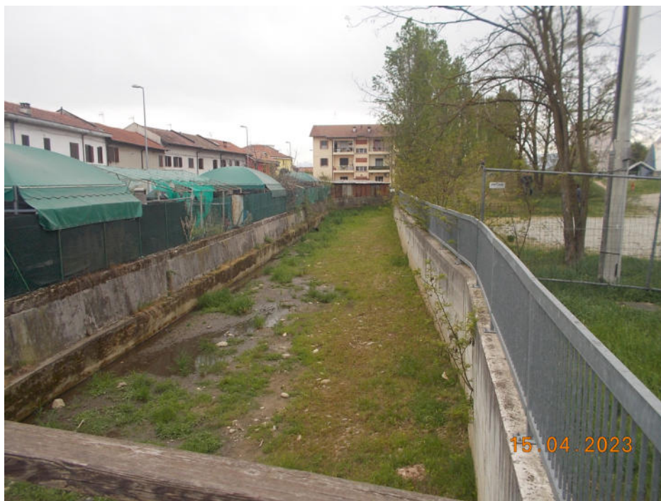
Figura 2-1 – Rio San Giovanni, vista verso monte dalla passerella pedonale. A destra della foto, l'area su cui insiste l'edificio in argomento (foto 3625-DSCN7218)
