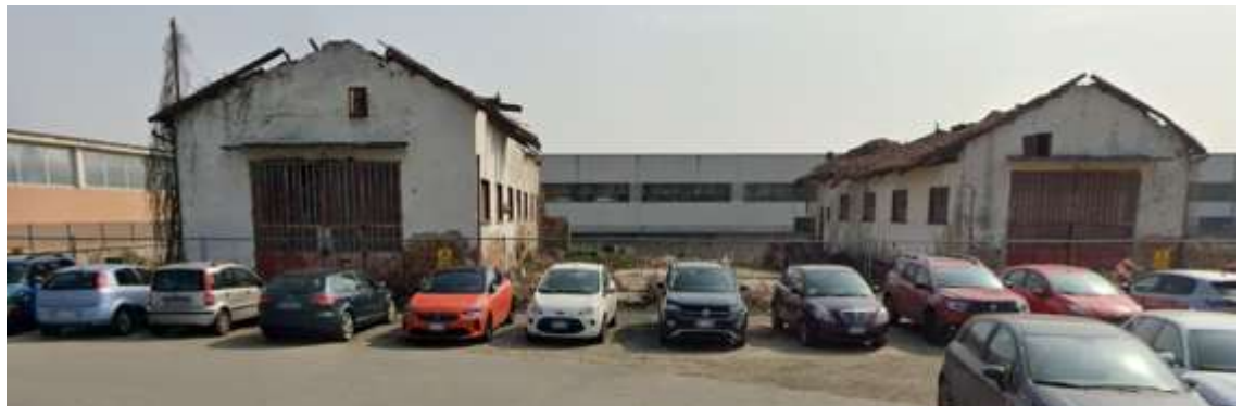
Vista del fabbricato esistente dalla via Torino
