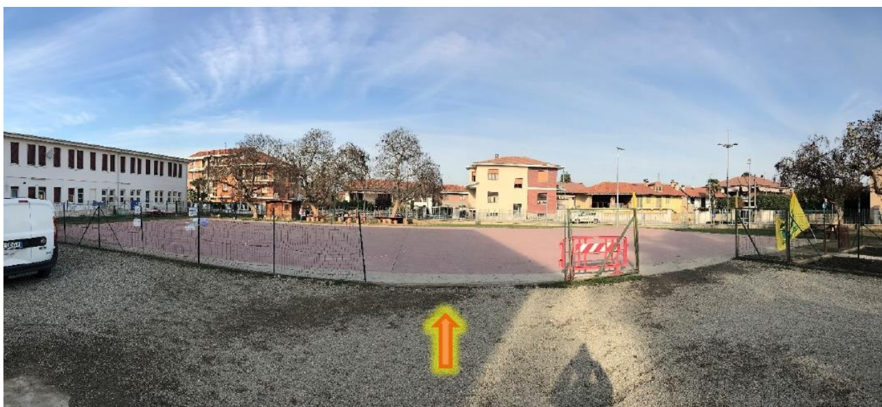
Vista dell'accesso dalla Scuola Primaria
